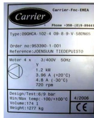
В табличке паспортных данных содержится следующая информация: информация об установлении контакта с изготовителем, назначение продукта, номер подтверждения заказа, технические данные вентиляторного электродвигателя, рабочее и испытательное давления, минимальная и максимальная рабочие температуры, внутренний объем, масса, месяц и год изготовления и маркировка ЕС.
